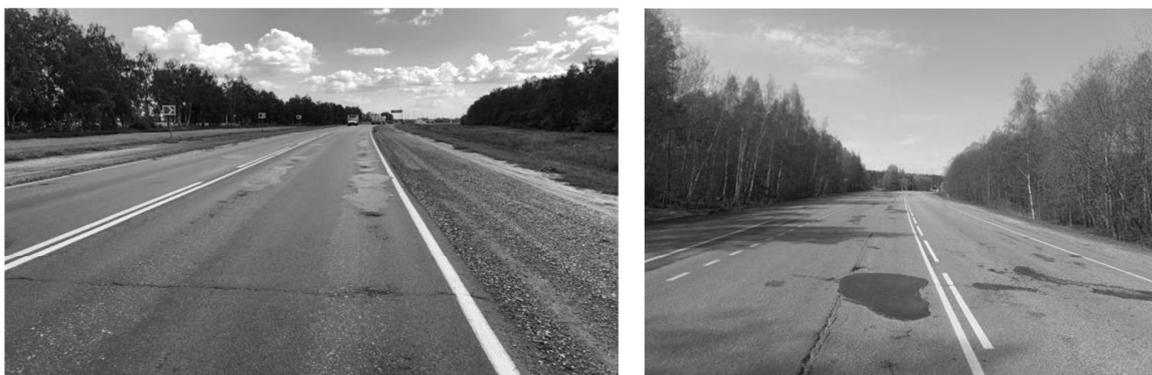
*Рис. 6. Отраженные трещины, повторяющие трещины в нижележащих слоях*
