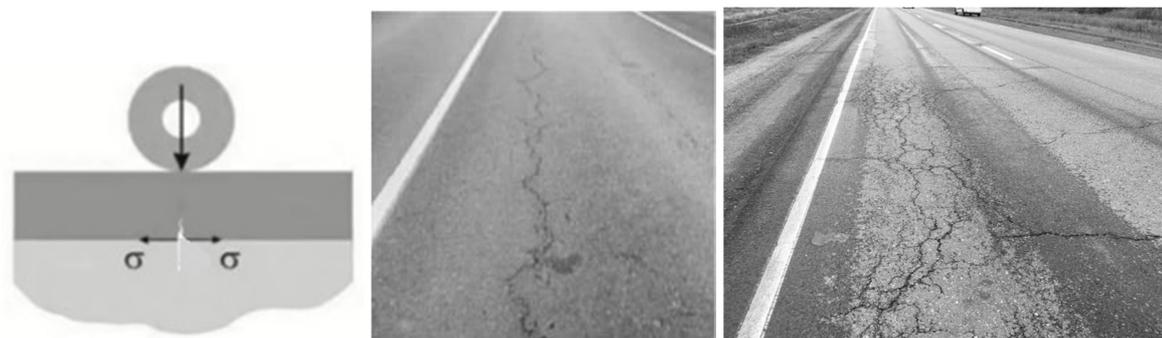
Рис. 1. Образование усталостных трещин на асфальтобетонном покрытии автомобильных дорог
