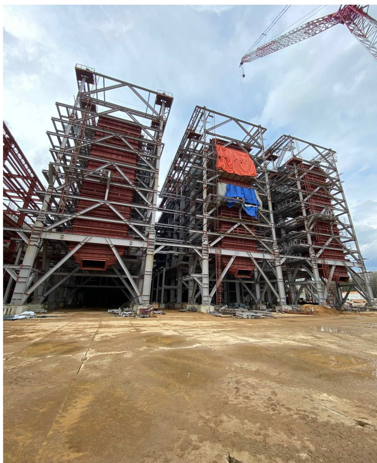
Рис. 6. Выварка экономайзеров вертикального газохода в проектное положение
