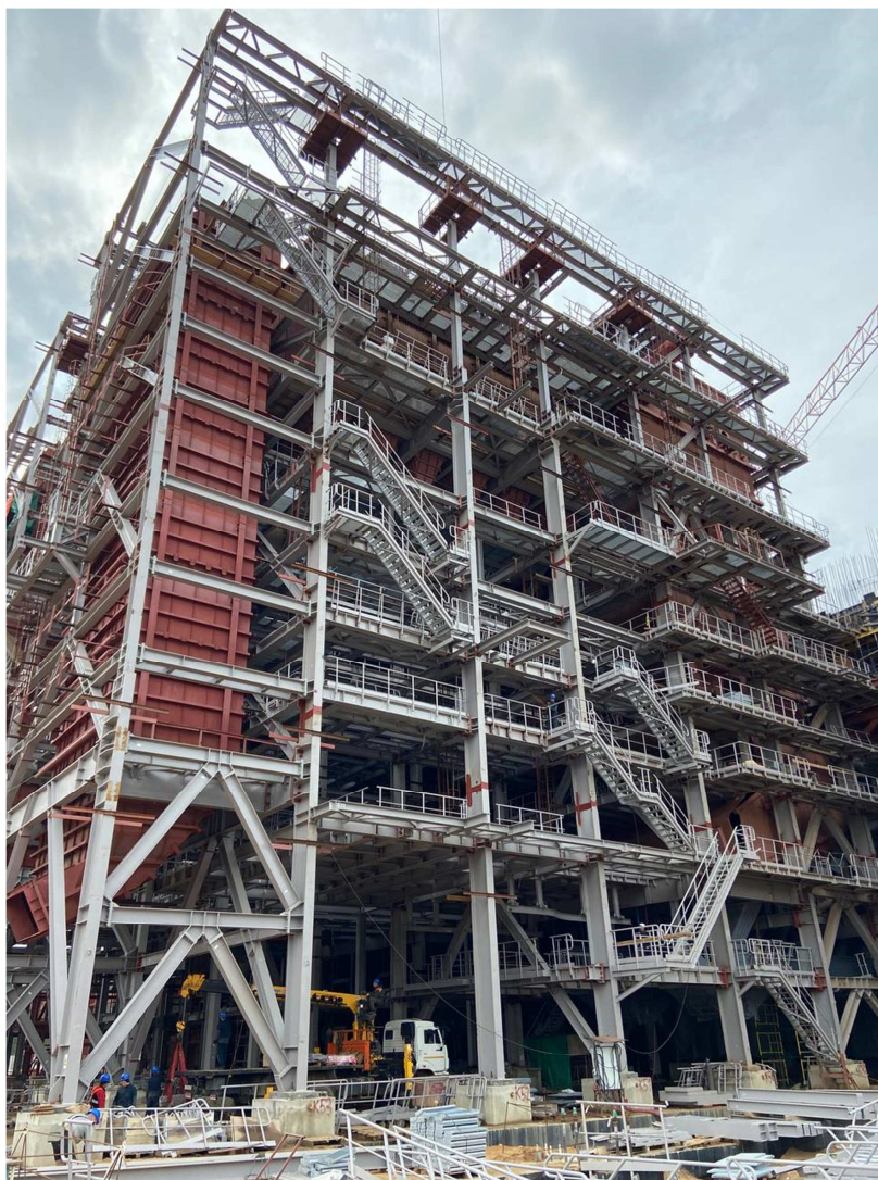
Рис. 8. Монтаж площадок и лестниц котла
