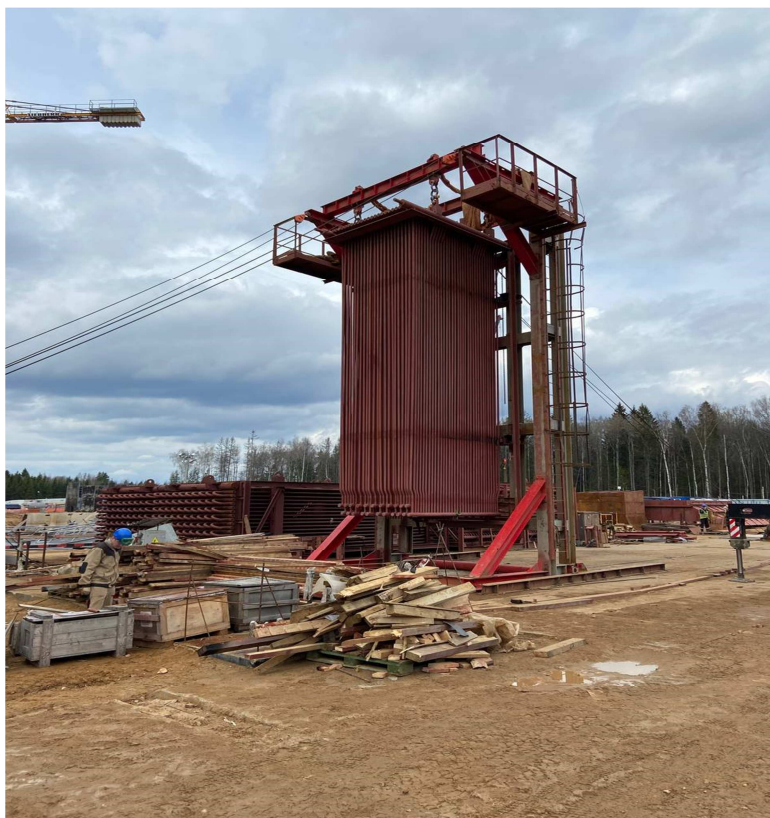
Рис. 5. Раскантовка пароперегревателя горизонтального газохода котла
