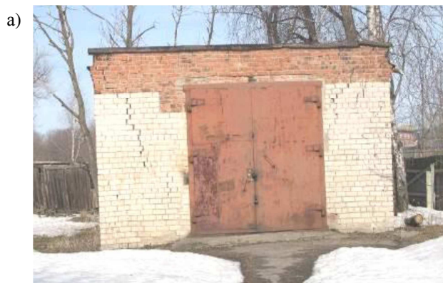
Рис. 2. Трещины в кирпичных стенах неотапливаемых зданий: а) объект в пригороде г. Вологды; б) незавершенный объект в поселке Можайское
