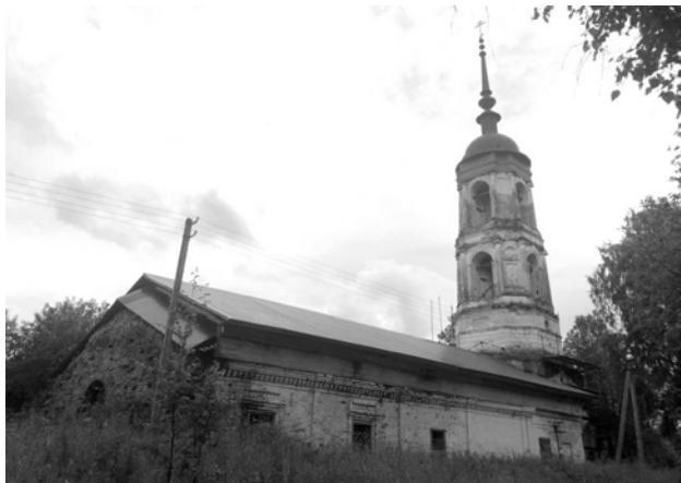
Рис. 2. Колокольня Николаевского прихода (2023 г.)
