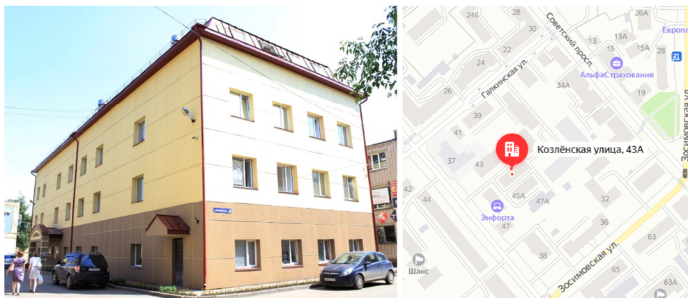
Рис. 1. Общий вид объекта тепловизионного обследования
