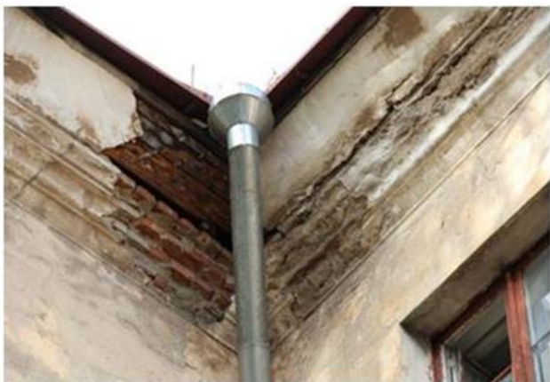
Рис. 5. Дефекты карнизной части стены
