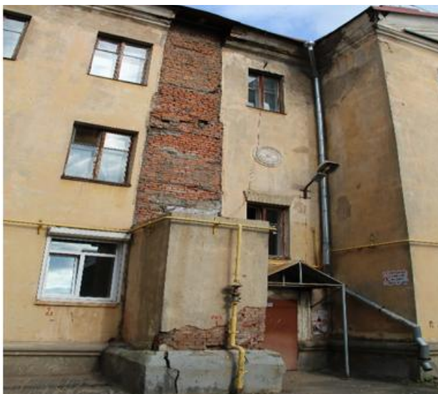
Рис. 4. Дефекты кирпичных стен
