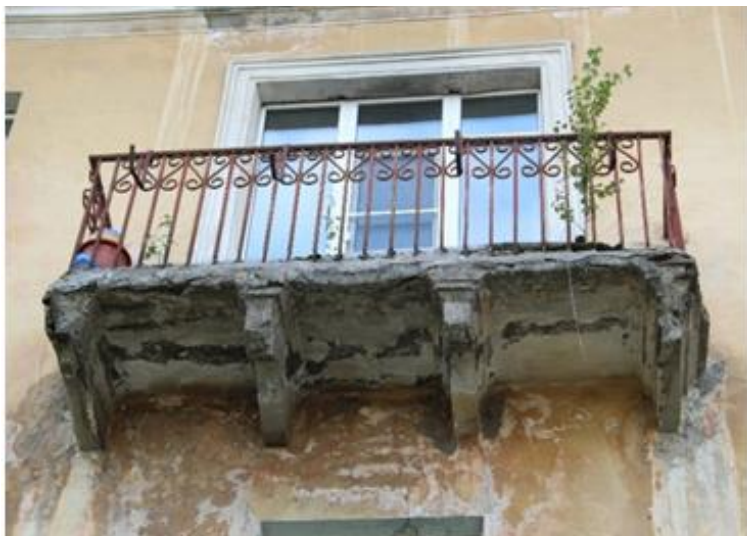
Рис. 6. Дефекты балконов и трещины в стене
