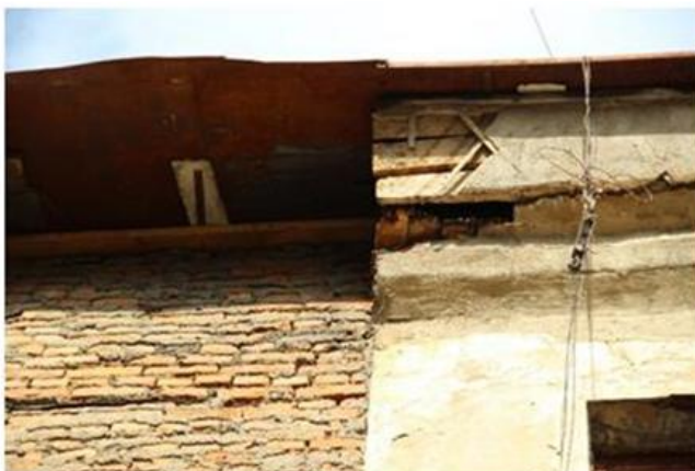
Рис. 5. Дефекты карнизной части стены
