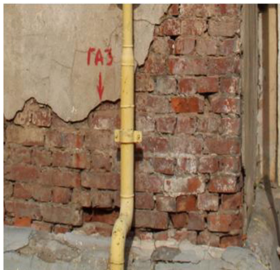
Рис. 4. Дефекты кирпичных стен
