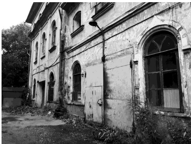
Здание бывшей следственной тюрьмы в Вологде. Фото А. Сберегаевой. 24.08.2019
