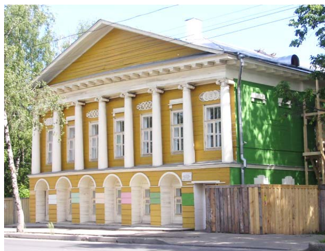
Рис. 7. Реставрационные работы на доме Левашовых. Фото 2005 г.
